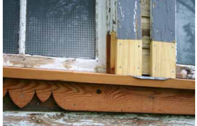
Église anglicane St. Paul, région de St-Francois-Xavier (Manitoba). Les nouveaux matériaux devraient être compatibles visuellement et physiquement avec les anciens.
